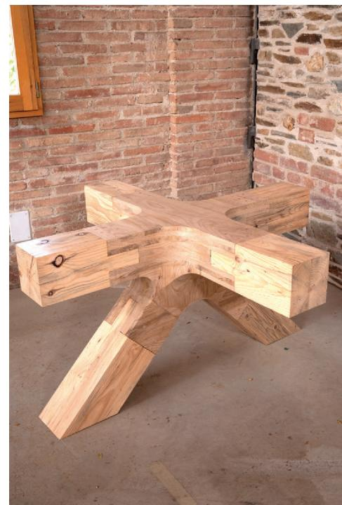
Este prototipo, inspirado en el proyecto CORA realizado por estudiantes del IAAC, es una estructura arbórea de madera compuesta por nodos producidos mediante fabricación digital y robótica. Estos nodos están concebidos para concentrar la complejidad, unificando columnas en forma de árbol con una estructura de techo de patrón Voronoi. Realizado con castaño, roble y pino.
